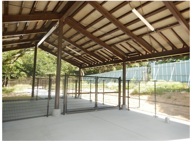
シェルター内部
