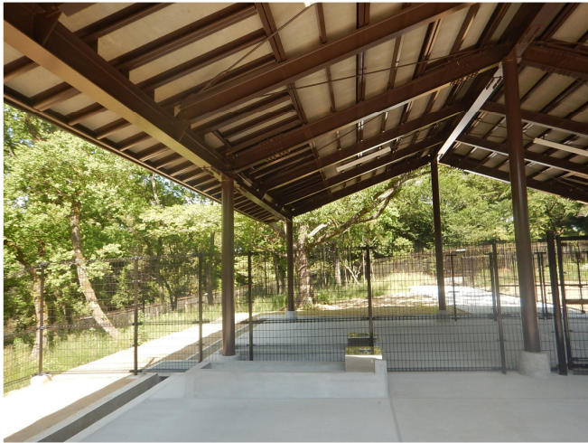
シェルター内部
